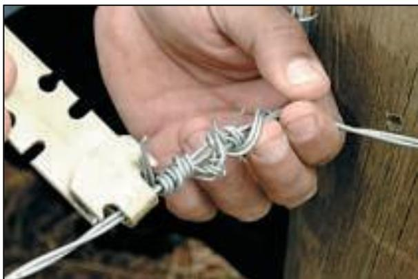
Figura 175 - Arremate no mourão esticador de canto de arame farpado.
