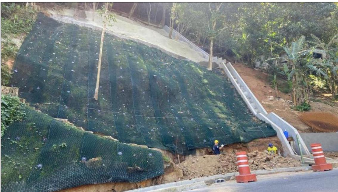
Figura 195 - Exemplo de obras de contenção via retaludamento, malha de contenção e projeção de ancoragem.
