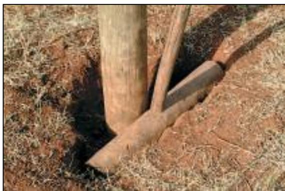
Figura 168 - Instalação do travesseiro para fixação do mourão.
