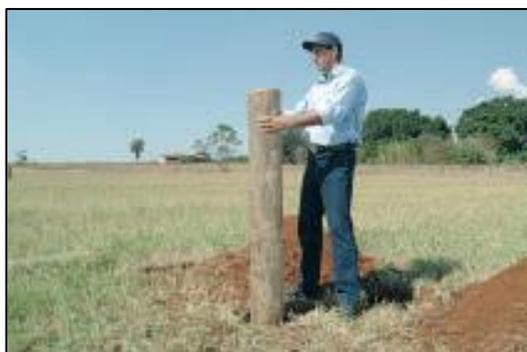
Figura 166 - Ajuste da altura do mourão.
