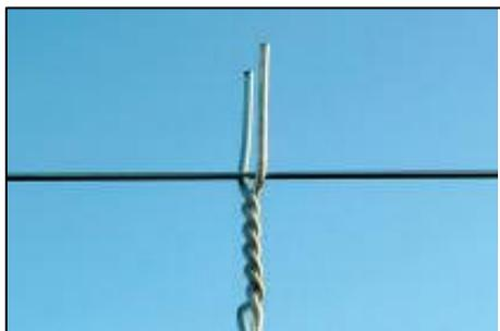
Figura 177 - Instalação do balancim.
