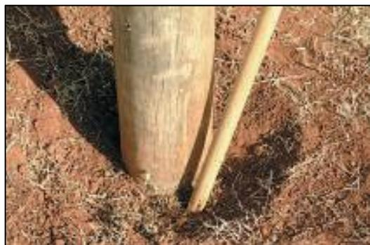
Figura 167 - Compactação do solo para fixação do mourão.
